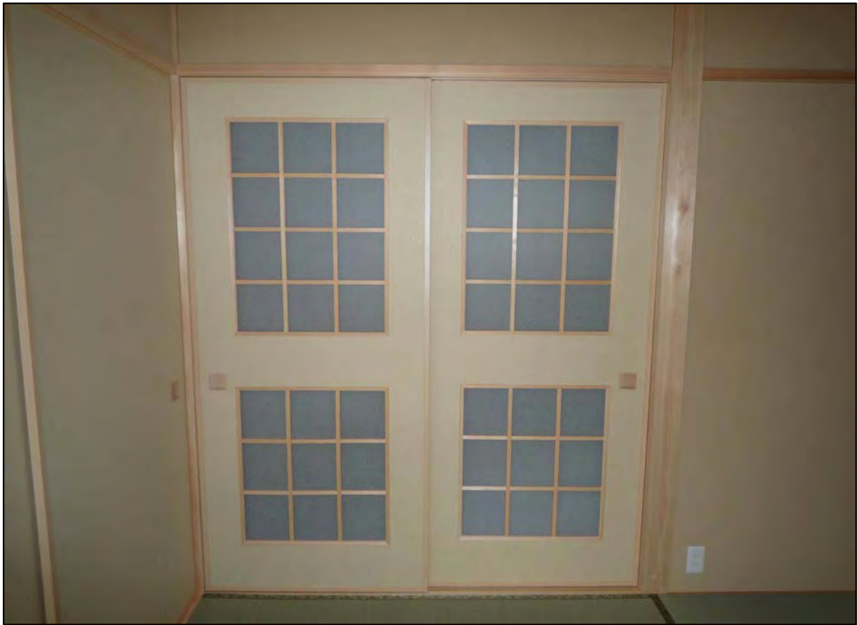
格子付き戸襖(洋間側) 引違 材質:強化紙合板+同材組子 アクリルワロン2mm
