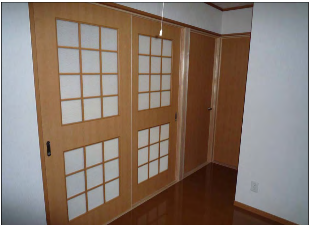
格子付き戸襖(洋間側) 引違 材質:強化紙合板+同材組子 アクリルワロン2mm
