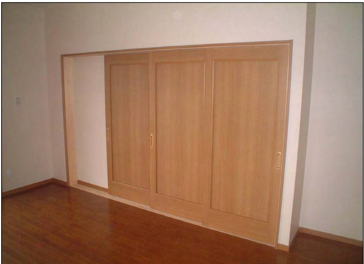
戸襖(和室側) 3本引き込み 材質:木目シート合板+同材フレーム(ダイケン)
