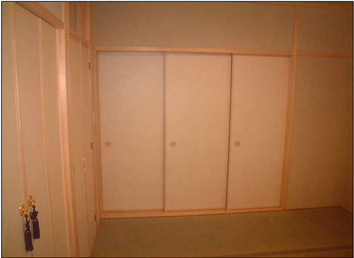
戸襖(和室側) 3本引き込み 材質:木目シート合板+同材フレーム(ダイケン)
